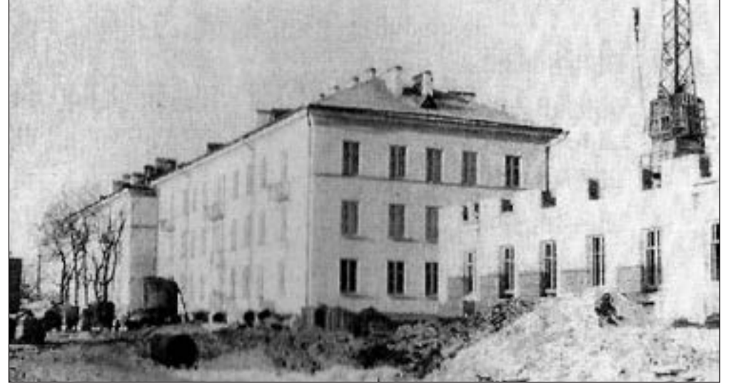
Строительство «Сталинских» домов для сотрудников ЛИЯФ на ул. Гагарина. На фото дома № 8, 10 и 12 (строящийся). 1950-60 гг.
